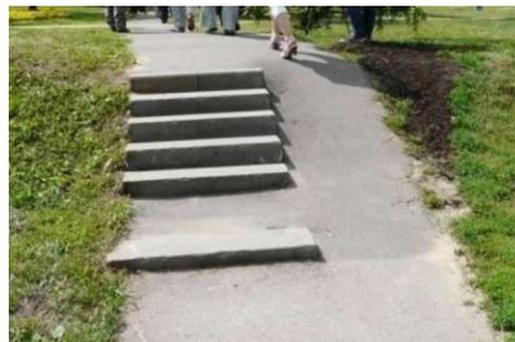
Уклон более 16,5 %, боковой уклон, отсутствуют бортик и поручни. Пандус не доступен.
