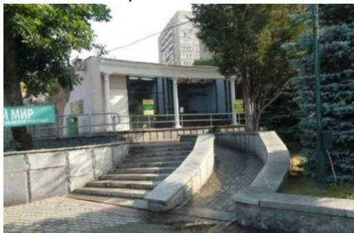
Повышенный уклон и отсутствие поручней. Частичная доступность.
