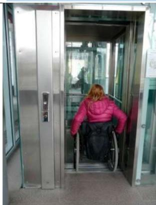
По Техническому регламенту о безопасности лифтов минимальные размеры кабины лифта, доступного для инвалида на кресле-коляске без сопровождающего, составляют 1,1x1,25 м. Развернуться на кресле-коляске в таком лифте на коляске нельзя, поэтому придется въезжать или выезжать задним ходом. Для безопасности инвалида на задней стене кабины должно быть зеркало.
