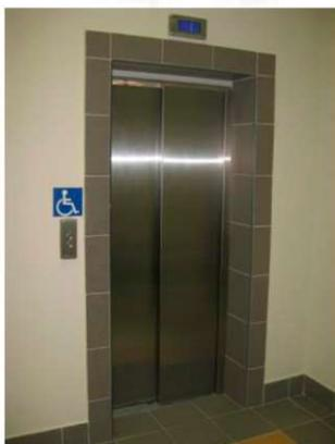
По Техническому регламенту о безопасности лифтов минимальные размеры кабины лифта, доступного для инвалида на кресле-коляске без сопровождающего, составляют 1,1x1,25 м. Развернуться на кресле-коляске в таком лифте на коляске нельзя, поэтому придется въезжать или выезжать задним ходом. Для безопасности инвалида на задней стене кабины должно быть зеркало.
