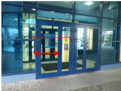
У двустворчатых дверей измеряется ширина рабочей створки при закрытой нерабочей (узкой) створке. Самостоятельно вторую створку, как правило, инвалид-колясочник открыть не может. Двустворчатые двери с рабочей створкой уже, чем 0,85 м будут частично доступными. В графе 6 «Примечание» следует указать «Есть вторая створка».
