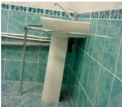
При наличии некорректно расположенного поручня (например, значительно ниже раковины, вплотную к раковине) эта особенность фиксируется в графе 6 «Примечание».
