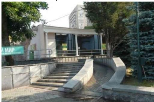
Повышенный уклон и отсутствие поручней. Частичная доступность.
