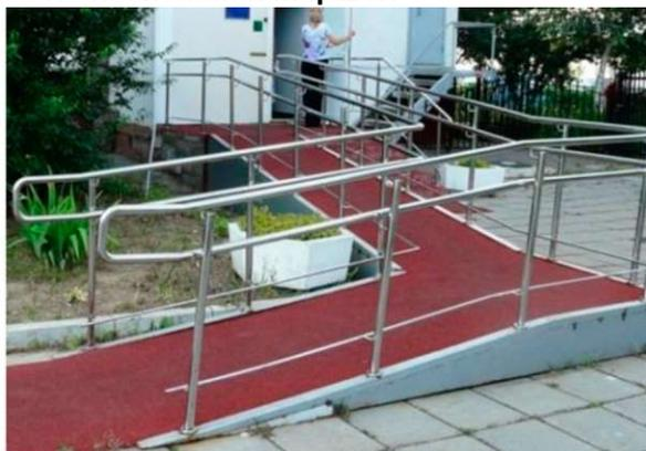
В Анкету обследования заносится максимальный уклон пандуса, т.е. выбирается уклон наиболее крутого участка. Обычно он бывает в начале марша. При использовании электронного угломера для повышения точности измерения следует измерить уклон в начале, середине и конце марша пандуса.
