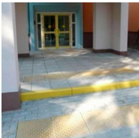
Для защиты от осадков обычно выполняют входную площадку высотой 0,15 м. Если к такой площадке выполнен пандус, то доступность для колясочников полная.
