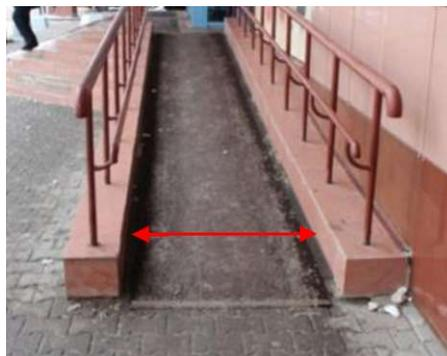
Ширина пандуса, как правило, измеряется между поручнями, если они имеются на пандусе. При отсутствии ограждения и поручней измерения производятся по ширине поверхности марша. В любом случае ширина измеряется в «чистоте», то есть в месте, где ширина передвижения минимальная.
