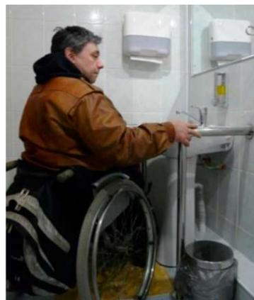
Часто под раковиной размещена тумба, пьедестал или экран. В этом случае возможно только боковое размещение кресла-коляски, доступность частичная.
