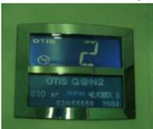
Световая информация в кабине представляет собой световой указатель с цифровым изображением, высвечивающий номер соответствующего этажа, и световой индикатор направления движения кабины (стрелка - вверх или стрелка - вниз).
