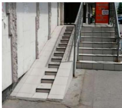
При уклоне пандусов более чем 16,5 % (более 1:6) объект считается недоступным для инвалидов на кресле-коляске. Для сравнения, уклон часто применяемых на лестницах металлических аппарелей составляет 50% (30° или %).
