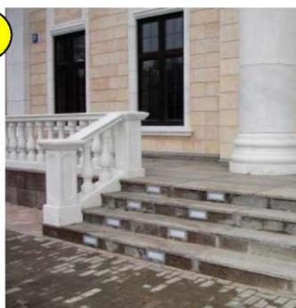
Частично доступно, перила не обеспечивают опорного передвижения
