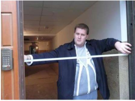
Измеряется ширина проема «в свету» при максимально открытой рабочей дверной створке. Как правило, это расстояние меньше на толщину дверного полотна.
